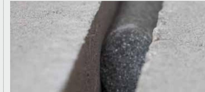
Hay que respetar las juntas estructurales de la piscina (si las hay) y realizar juntas de dilatación cada 25 m<sup>2</sup> y/o 5 metros lineales como máximo.
