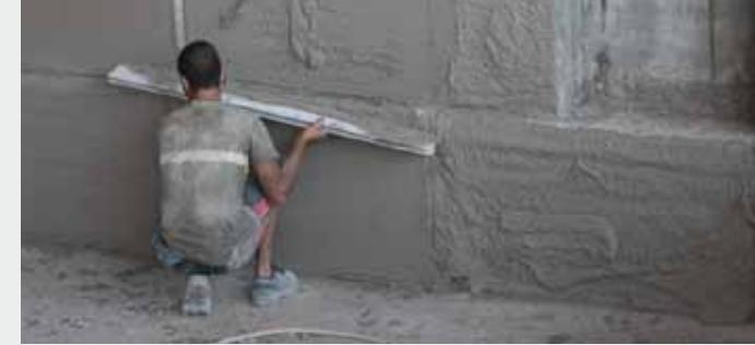
Recrcido de las paredes Levelling mortar for walls Chapes des parois
