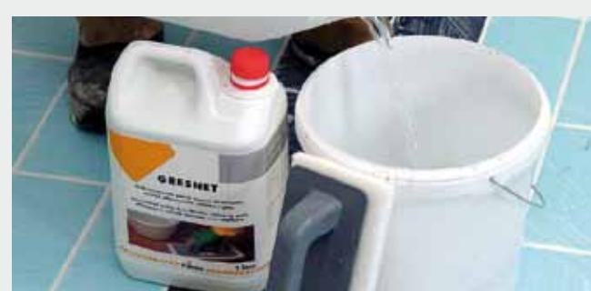
Solo en el caso de tener restos de material de rejuntado muy adheridos, usaremos -pasados tres días- el ácido limpiador **GRESNET** diluido con agua en una proporción ácido: agua del 1:10.
