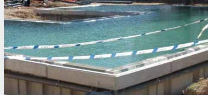
Prueba de estanqueidad Proof of water-tightness Test d'étanchéité
