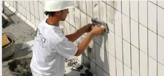
Otra forma de mejorar la estanqueidad del vaso es usando un mortero 100% estanco, flexible y antiácido tipo **CERPOXI**.
