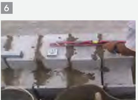
Para el relleno del murete perimetral los bloques S9 sirven de encofrado.
