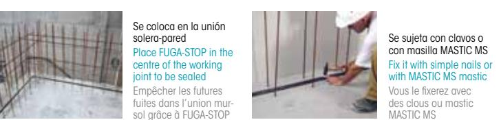
**sellado de la unión PVC-hormigón**
